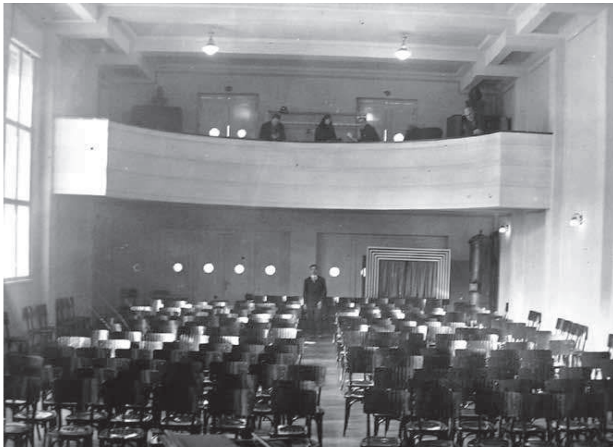
Divadelní sál, pohled do hlediště s balkonem (říjen 1928)
